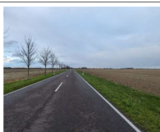
Abbildung 3: Blick auf die südliche angrenzende Landesstraße L57.
