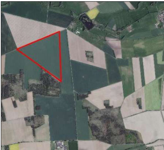
Abbildung 1: Lage des vBPlan Nr. 03/2024 „AGRI-Photovoltaik Silberberge“ (Quelle: Datenlizenz Deutschland - DOP100 - Version 2.0 © GeoBasis-DE / LVermGeo ST)
