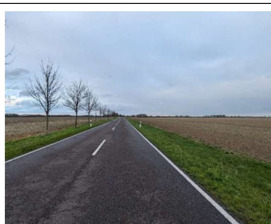
Abbildung 3: Blick auf die südliche angrenzende Landesstraße L57.
