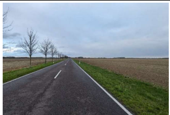
Abbildung 8: Blick auf die südliche angrenzende Landesstraße L57.
