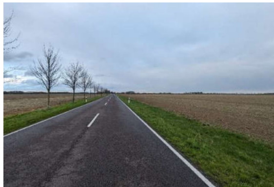
Abbildung 8: Blick auf die südliche angrenzende Landesstraße L57.
